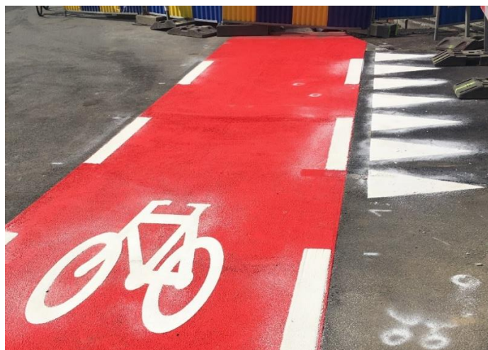
Figuur 1.9: Fietspad hersteld na kabelwerken
