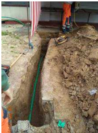
Figure 1 : Exemple de propreté d'une tranchée de raccordement en domaine privé
