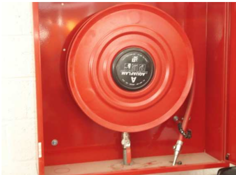
Figure 18 : Dévidoir à alimentation axial seul
