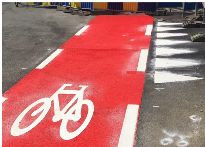
Figuur 1.9: Fietspad aangelegd na kabelwerken
